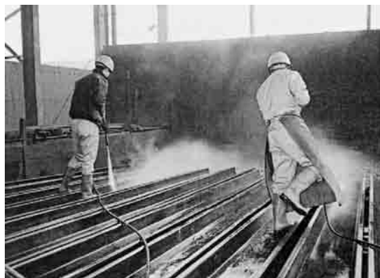
鋼矢板の洗浄
