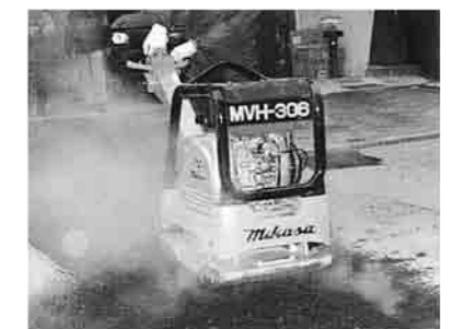
アスファルト転圧
